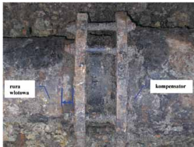
Fot. 4. Ślady rozsunięcia kompensatora gazociągu DN200 Photo 4. Traces of the pipe movement in the expansion joint of gas pipeline DN200
