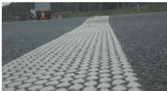
Rys. 2. Próg wzdłuż linii krawędziowej (Grygierek M.)
