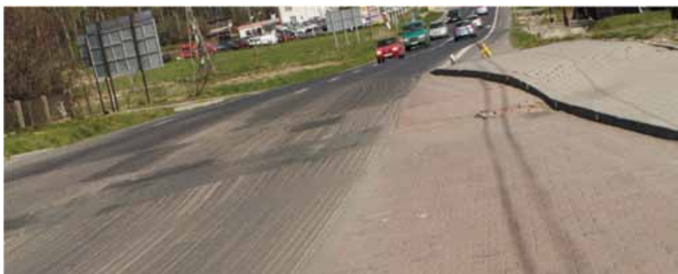
Rys. 13. Deformacja nieciągłe – przypadek C (fot. Grygierek M.) Fig. 13. Discontinuous deformation – case C (photo Grygierek M.)
