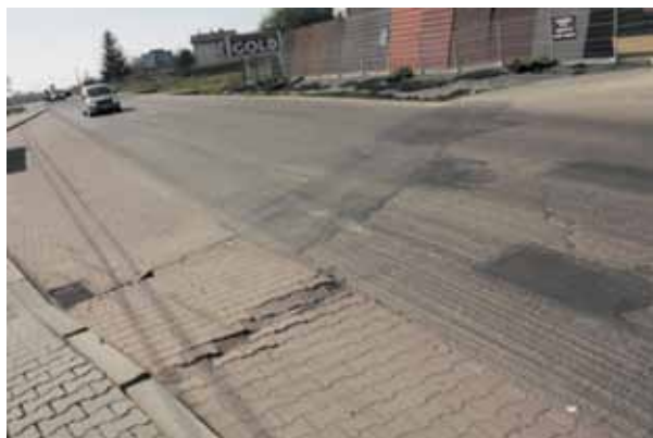
Rys. 12. Deformacja nieciągłe – przypadek C (fot. Grygierek M.) Fig. 12. Discontinuous deformation – case C (photo Grygierek M.)
