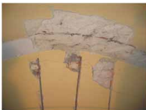
Rys. 4. Naprawa spękań przy zastosowaniu systemu Helifix Fig. 4. Repair of cracks using the Helifix system
