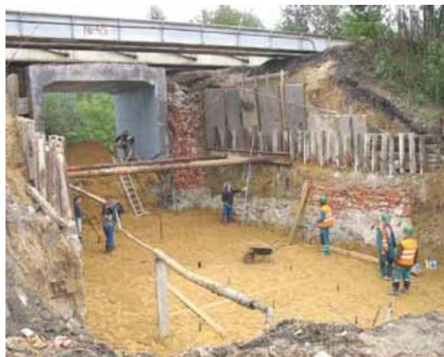
Rys. 11. Wykonywanie poduszki piaskowej [9] Fig. 11. Making the sand layer [9]
