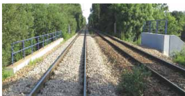
Rys. 14. Widok na tor na wiadukcie po przebudowie [9] Fig. 14. View on railway track no. 1 after rebuilding [9]
