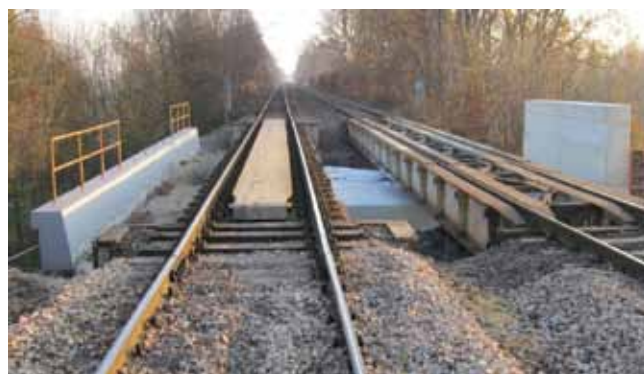
Rys. 12. Widok na konstrukcje odciążające [9] Fig. 12. View on the structure lightning [9]
