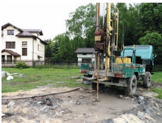
Rys. 9. Wiercenie otworu dla potrzeb uzdatnienia podłoża w 2013 r. (Fot. S. Tomecka-Suchoń)
