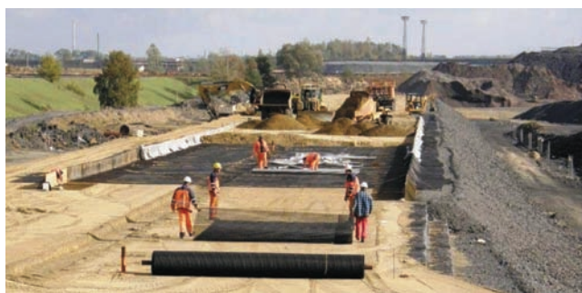
Rys. 6. Formowanie konstrukcji zbrojących – wykorzystanie szalunków przestawnych oraz „rowka naciągowego”
