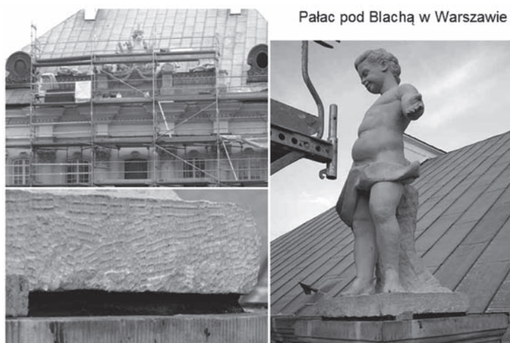
Rys. 8. Mocowanie figur na fasadzie Pałacu pod Blachą Zamku Królewskiego w Warszawie [5]
