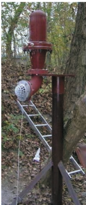
Rys. 9. Zamontowana gaśnica o pojemności 10 dm 3 przygotowana do próby [5] Fig. 9. Installed extinguisher of capacity 10 dm 3 prepared for test [5]
