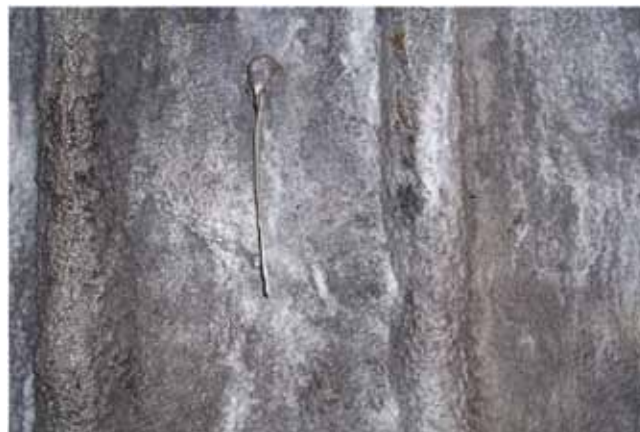
Rys. 7. Powłoka – torkret TSM 70 Fig. 7. Coating – gunite TSM 70
