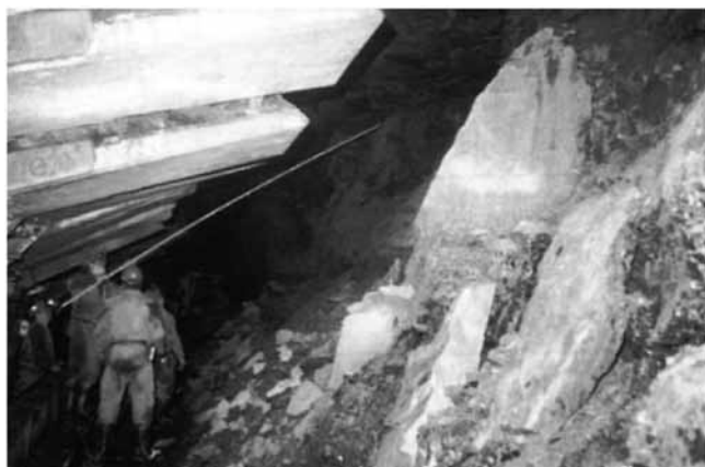
Rys. 3. Obwał skał stropowych w ścianie w jednej z kopalń w Stanach Zjednoczonych [14]
