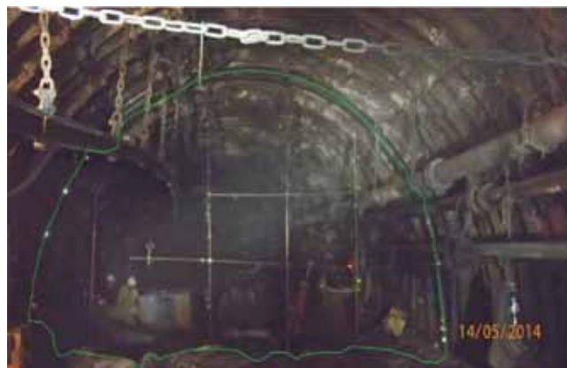
Rys. 1. Zdjęcie miejsca pomiaru w chodniku nadścianowym ściany G-6
