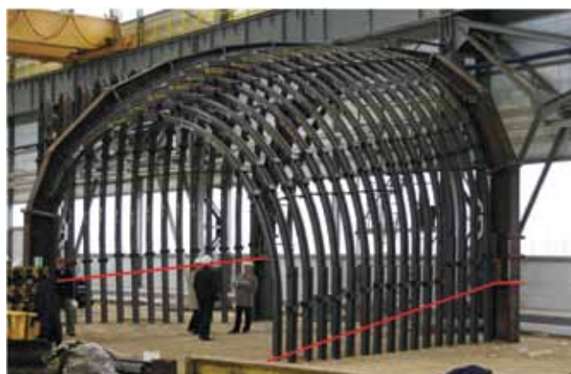
Rys. 8. Obudowa w trakcie montażu próbnego. (Liniami zaznaczono poziomy posadowienia odrzwi)
