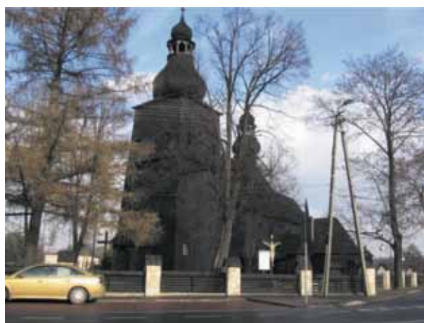
Fot. 1. Widok budynku kościoła od strony południowo-zachodniej Photo 1. View of the church from the south-west
