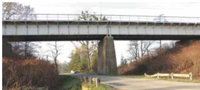
Rys. 1. Widok od strony wschodniej na most [6] Fig. 1. View of the east side of the bridge [6]
