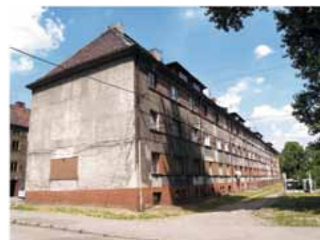
Rys. 3. Widok ogólny od strony południowo-wschodniej na szereg „b”
