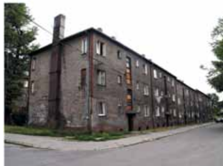
Rys. 2. Widok ogólny od strony południowo-wschodniej na szereg „a”
