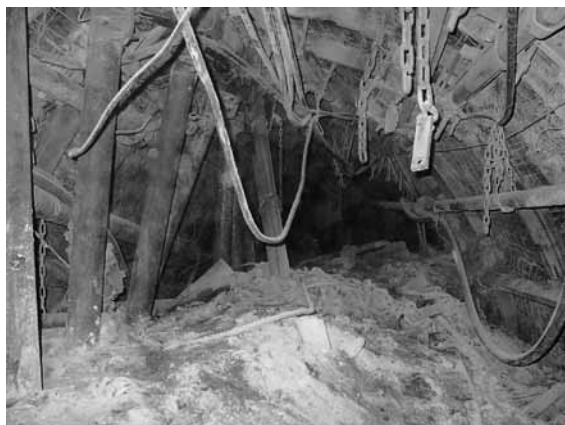
Rys. 4. Wypiętrzenie spągu powstałe wskutek nadmiernych obciążeń dynamicznych i kruchego łamania się warstw
