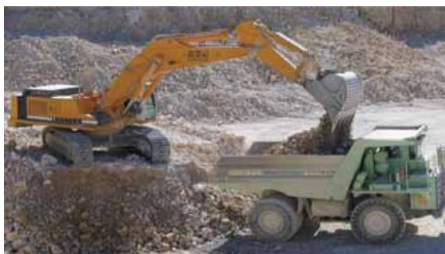
Rys. 3. Załadunek wozidla technologicznego przez hydrauliczną koparkę podsiębierną realizowany z pryzmy urobku Fig. 3. Loading of the off-highway dump truck by hydraulic backhoe excavator
